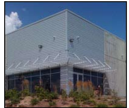
Intuit Data Center
